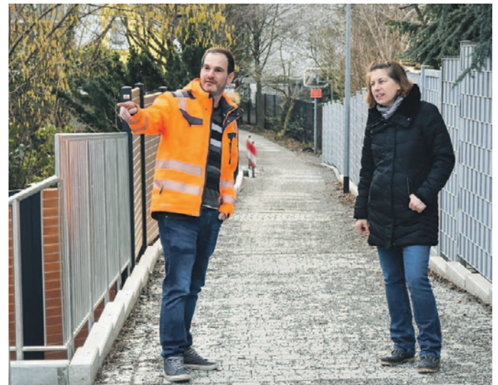
Doreen Hörtl (Soziale Angelegenheiten) und Georg Viehbeck (Tiefbau) machen sich vor Ort ein Bild vom Umbau.
